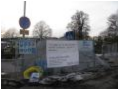
220 kV kablar Danderyd-Solna (DS2015-00390)
