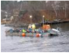
220 kV kablar Danderyd-Solna (DS2015-00413)
