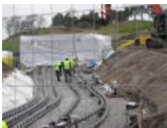
220 kV kablar Danderyd-Solna (DS2015-00410)
