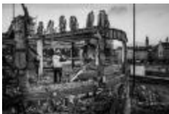
Rivning av Slussen (DS2017-00663)
