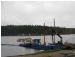
220 kV kablar Danderyd-Solna (DS2015-00407)
