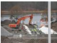
220 kV kablar Danderyd-Solna (DS2015-00409)
