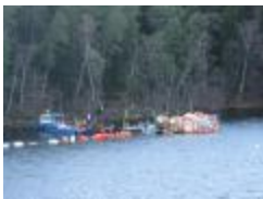
kommunikation, högspänningsnät, sjökabel 2 (DS2015-00386)
