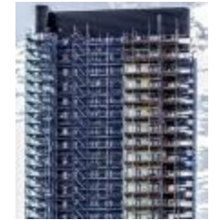
Under uppförande (DS2014-00050)
