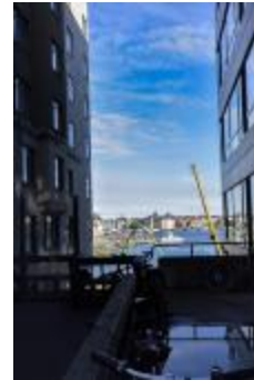
Sthlm under renovering (DS2017-00637)
